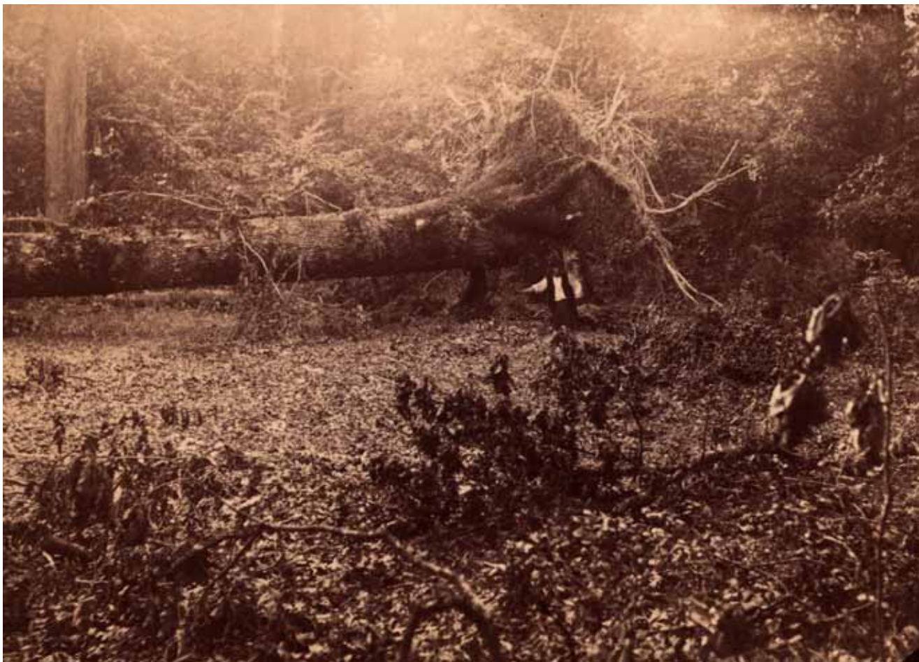
Srušena stabla nakon tornada u Novskoj 31. svibnja 1892. Fotografija je snimljena oko dva tjedna nakon događaja, tijekom Mohorovičićevog obilaska pogođenog područja.
