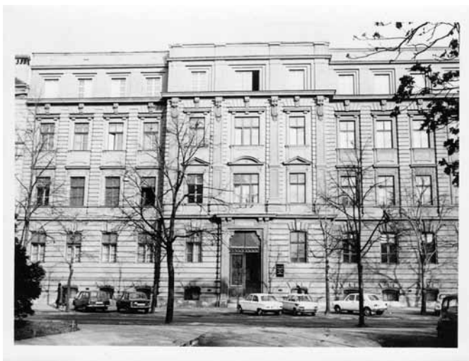
Slika 32. Pročelje zgrade na adresi Rooseveltov trg 6 tijekom 70-tih g. 20 st., gdje je i danas smješten Zoologijski zavod
