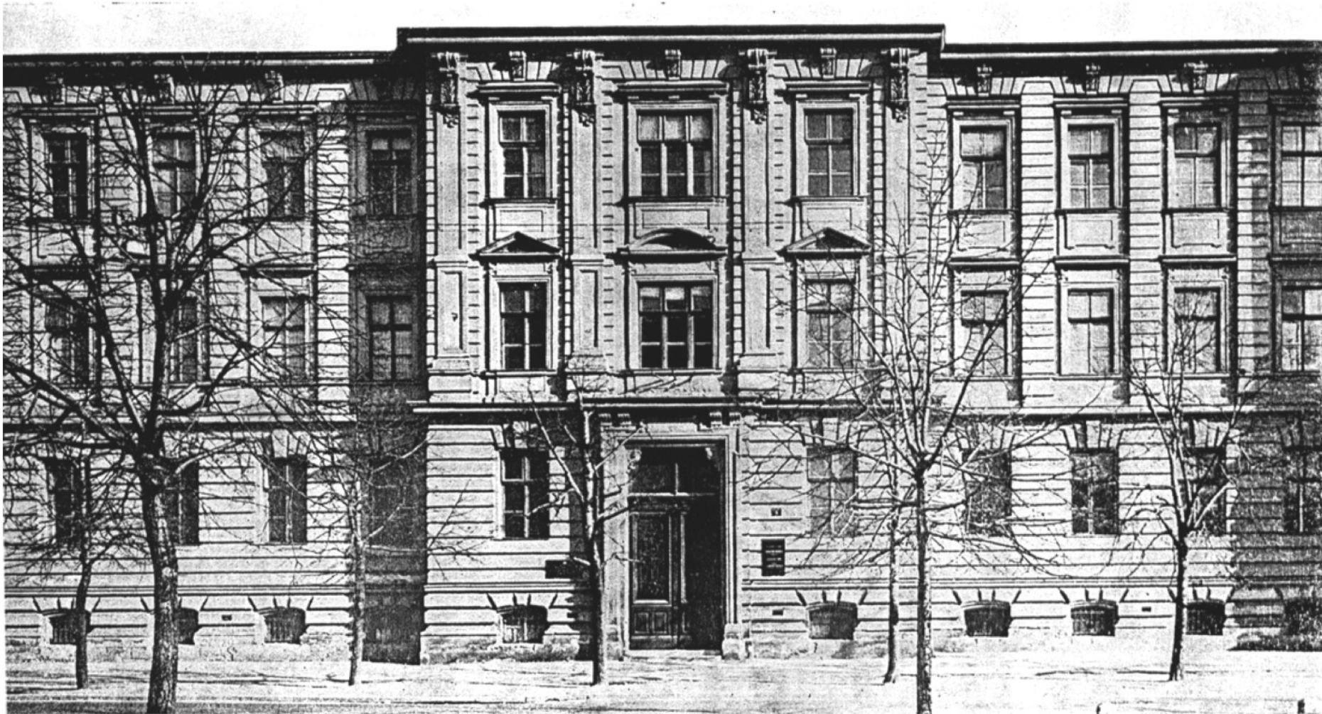
Zgrada Tehniške visoke šole na Roosveltovom trgu prije nadogradnje
