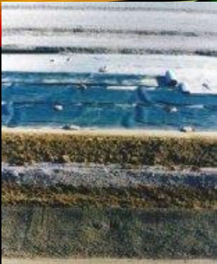
Izvedba brtvenog sloja
