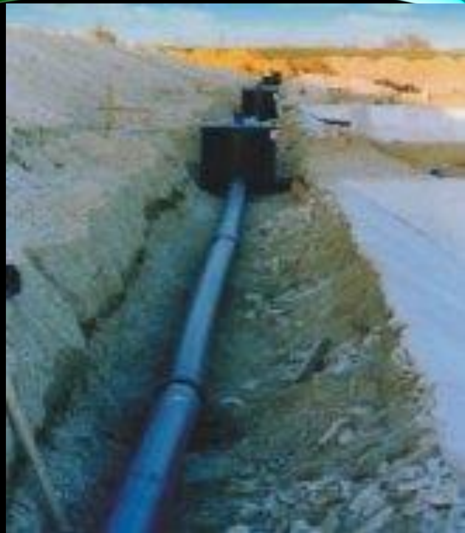
Ugradnja drenažnih cijevi
